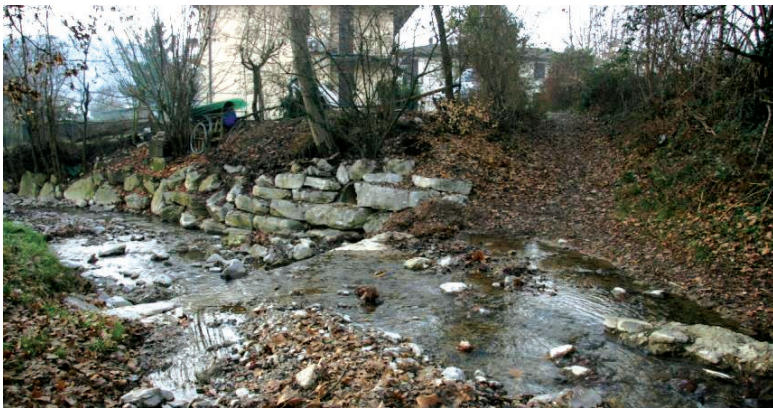
Valle di via XXVIII Maggio: prima dei lavori
